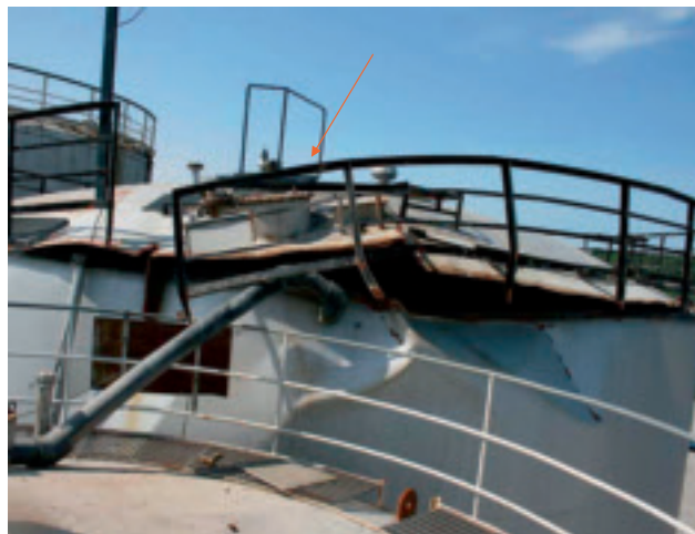
Taket på lagringstanken, pilen viser til åpningen i tanktaket.
